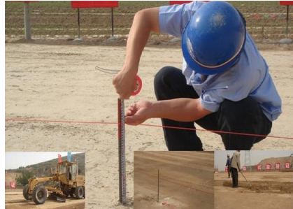
图 3-6 挂线法控制填土现场施工
