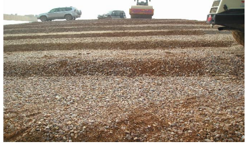
图 3-4 路堤分层填筑施工现场
