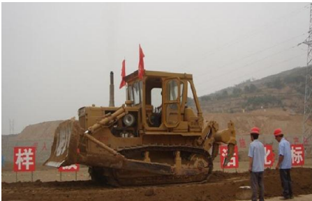
图 3-7 推土机初平现场施工
