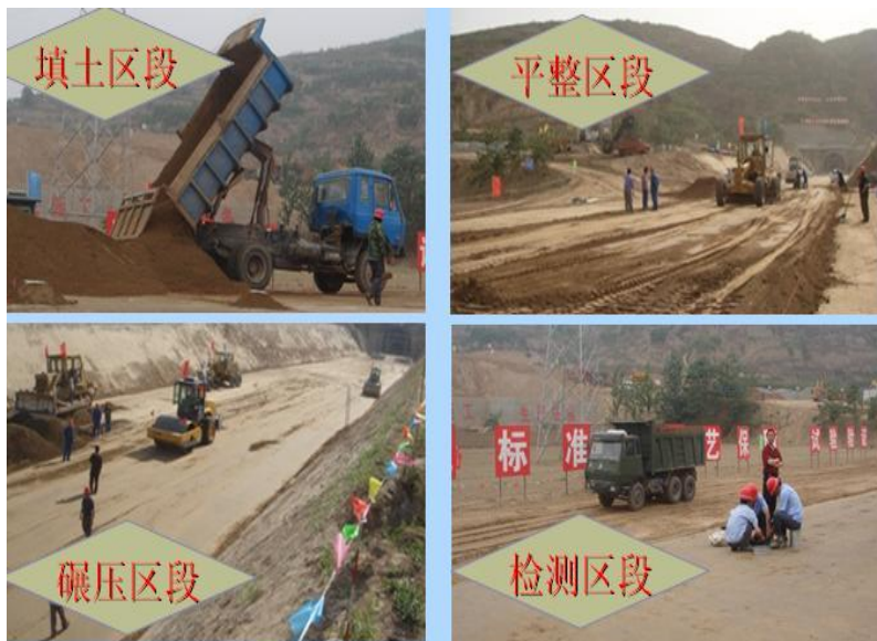
图 3-1 四区段施工现场
