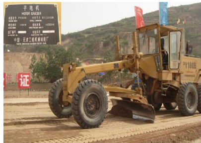
图 3-8 平地机精平现场施工
