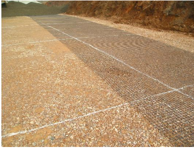
图 3-5 方格网法控制填土现场施工
