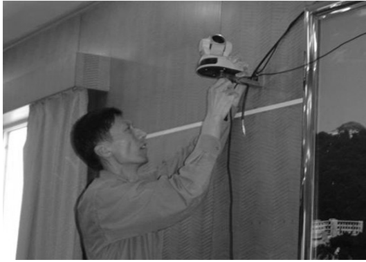
图 2.4.5 监控摄像头的安装
