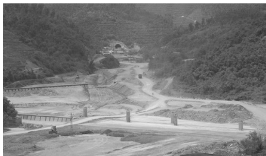
图 1 路堑超高边坡工点地形
