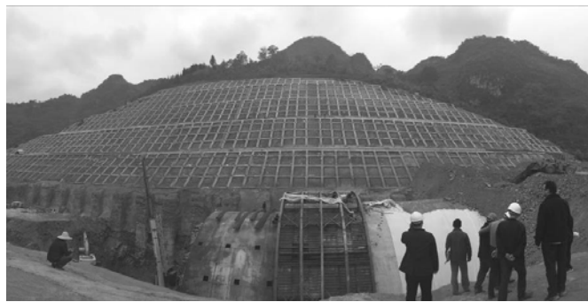
图 6 施工过程中的白腊寨四线明洞
