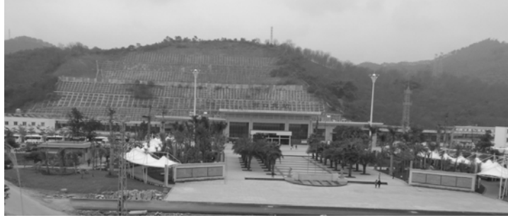
图7 边坡工程施工完毕的远景效果
