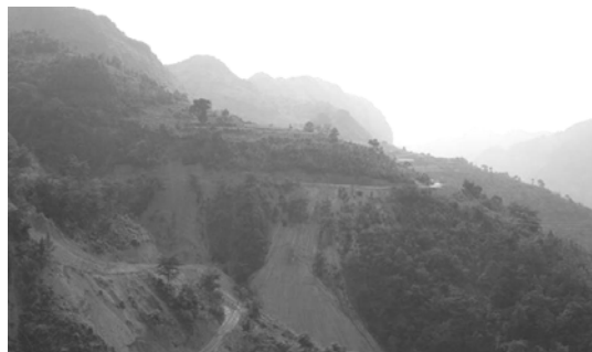
图 1 路堑高边坡工点地形
