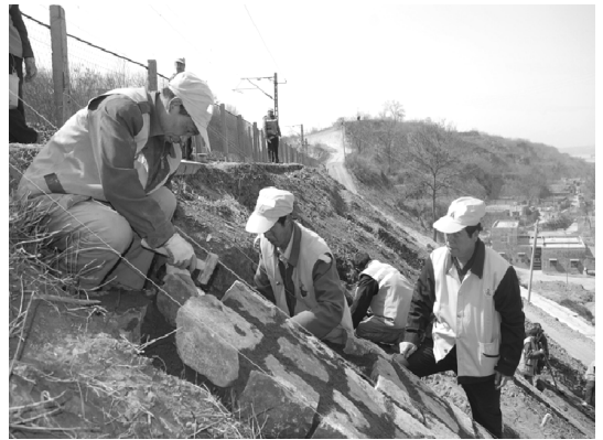
(b) 路基石砌护坡
