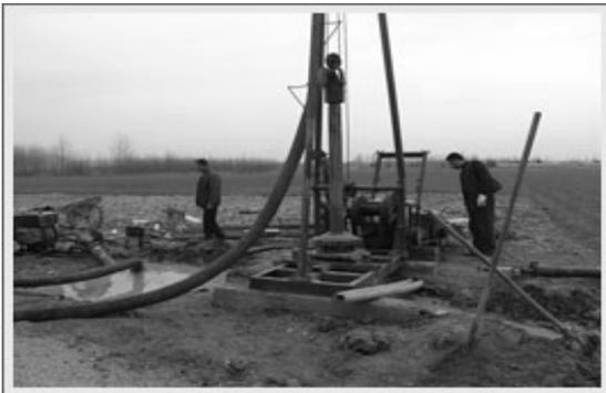
图 3.10 反循环钻机
