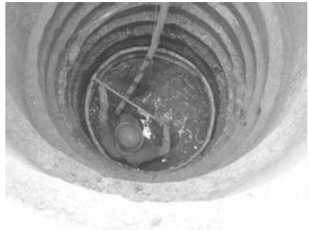
图 3.7 挖孔桩施工主要程序
