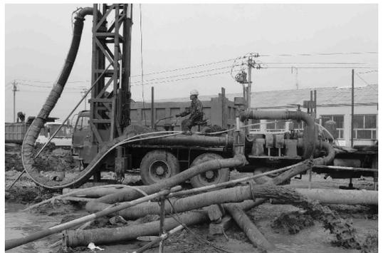
图 3.11 正循环钻机
