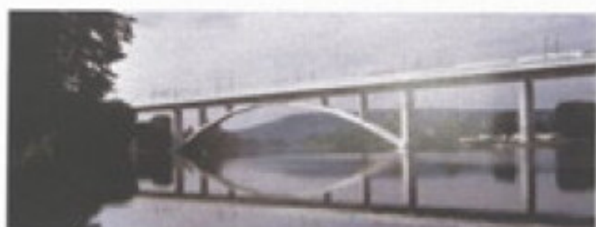
梅尼托埃湖上的铁路桥（Mainstal Rail Bridge）是德国对 那独特设计的组合结构
