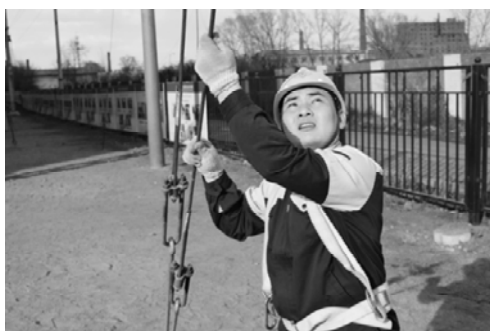
图 1.14 检查拉线状态
