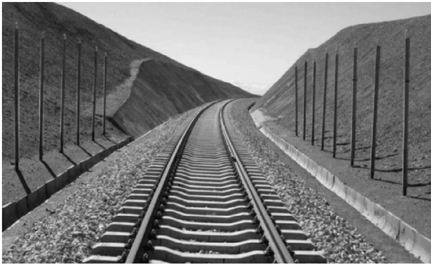
图 1-12 青藏铁路（线路两侧为热棒）
