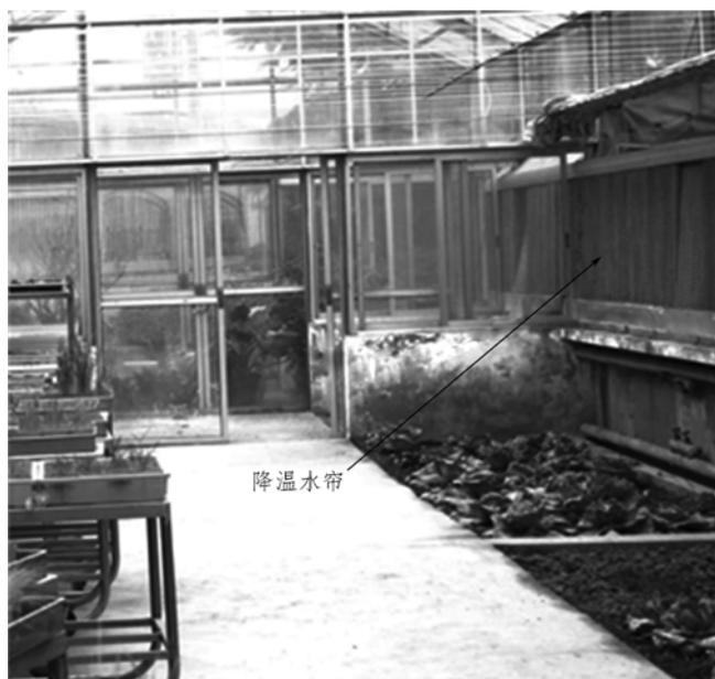
图 1.7 小型温室中冷水降温装置
