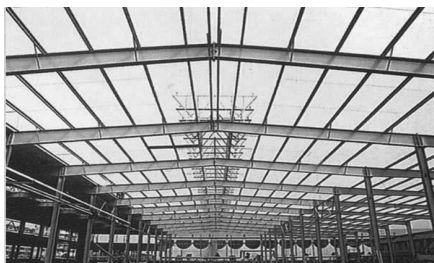
图 1-39 钢结构工业厂房
