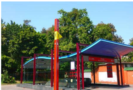
图 2.2.4 广州地铁中大站 A 出入口
