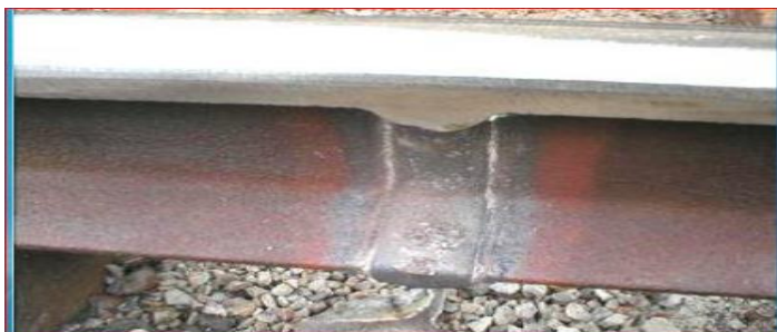
图 1-13 焊接接头
