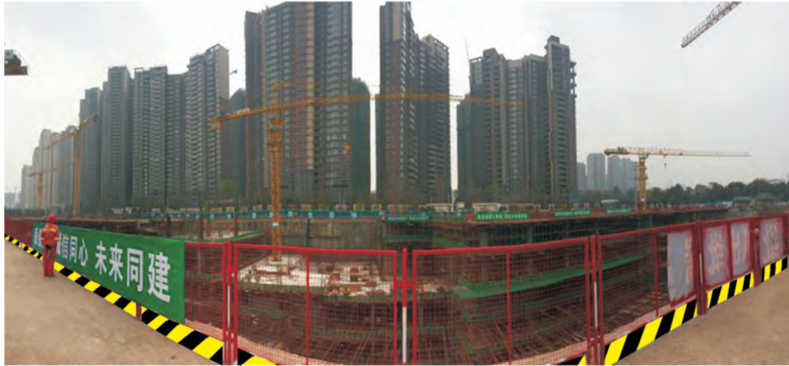
基坑临边防护安装效果图
