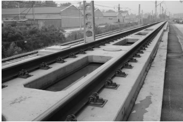
图 1-14 框架型板式无砟轨道
