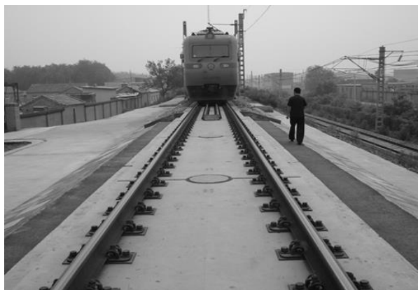
图 1-13 普通板式无砟轨道施工
