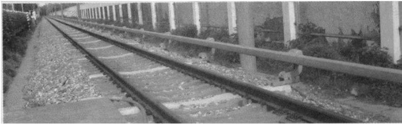
图 0-5 接触轨式接触网
