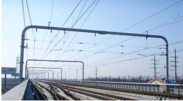
图 0-4 架空式接触网
