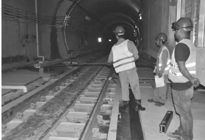
图 1-4 地铁验电操作
