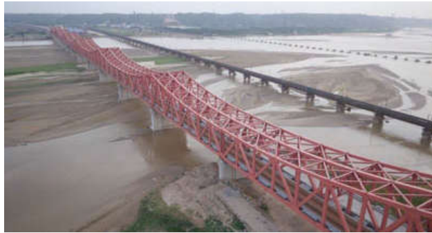
图 1-3 郑焦城际铁路黄河特大桥
