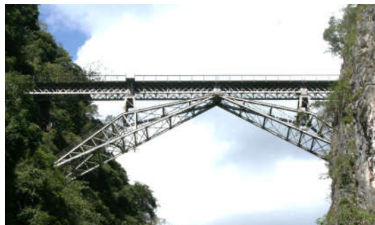
图 1.1.1-2 滇越铁路保姑人字桥
