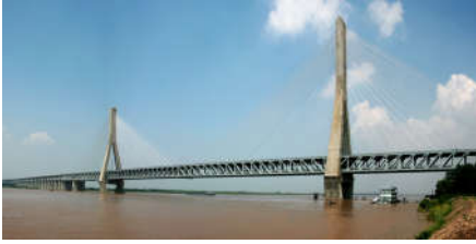
图 1.1.2-8 武汉天兴洲长江大桥
