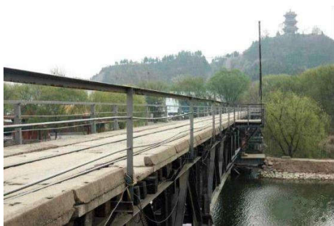
图 1-1 郑州“黄河第一铁路桥”平汉铁路郑州黄河大桥
