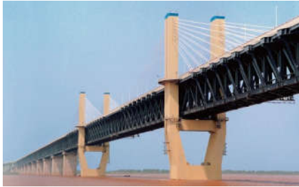
图 1.1.2-5 合芜铁路芜湖长江大桥
