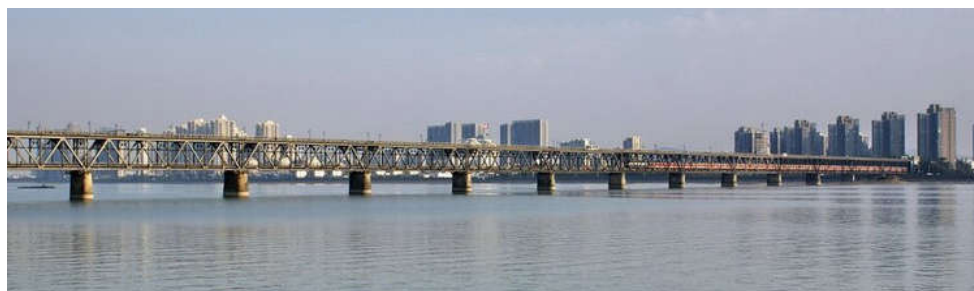
图 1.1.1-3 浙赣铁路钱塘江大桥
