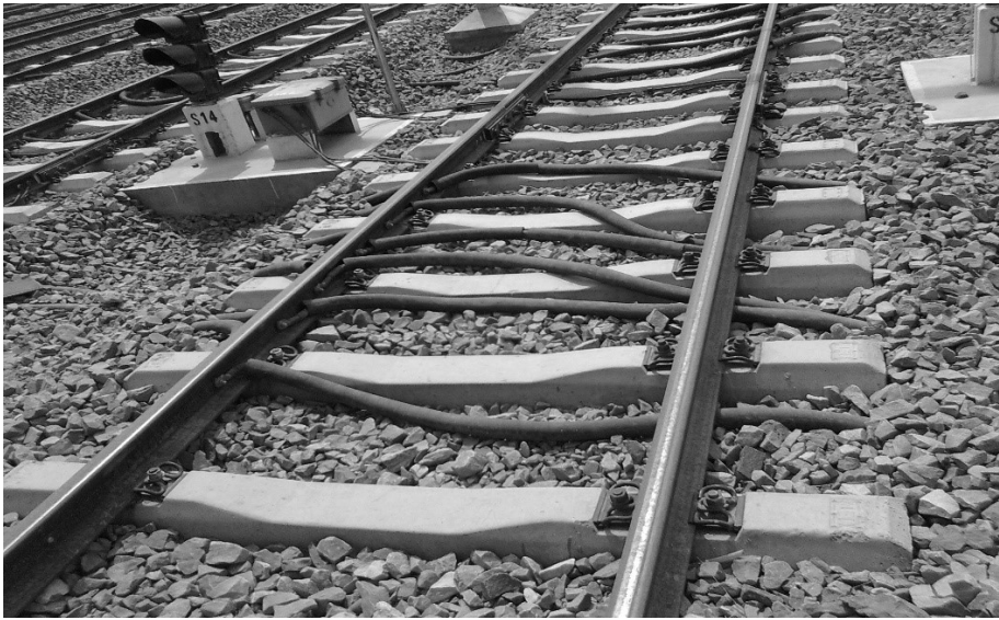
图 1-3 轨枕及连接件
