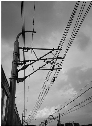
图 1-4 柔性架空接触网
