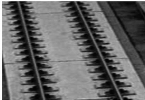
图 1-2 CRTS II型板式无砟轨道线路
