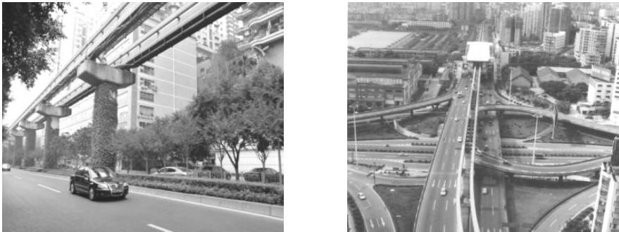
图 1.1-7 跨座式单轨系统高架区间
