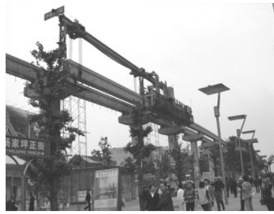
图 1.1-9 跨座式单轨轨道梁制作及架设
