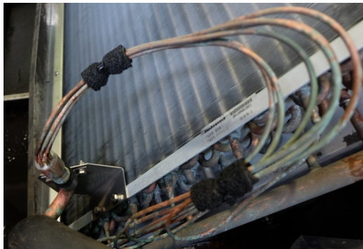
图 1-12 毛细管外观及在机组中的安装位置
