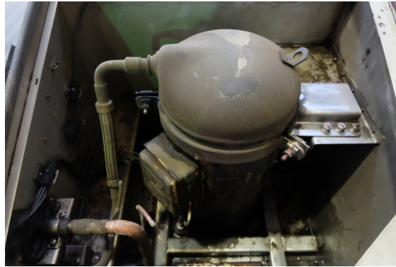
图 1-6 制冷压缩机在空调组中的安装位置
