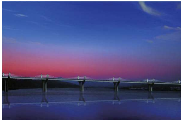
图 1.11 Gum-ga Grand Bridge (高 GA 大桥)
