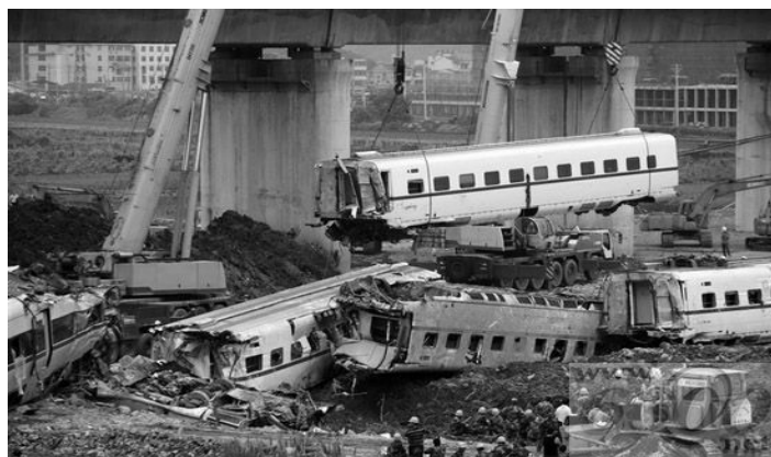
图 1-2 7·23 事故救援现场
