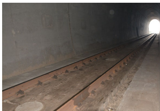
图 1-2 赣龙线枫树排隧道内 CRTS 型板式无砟轨道
