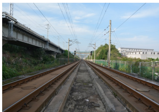
图 1-3 遂渝线无砟轨道试验段 CRTS 型板式无砟轨道
