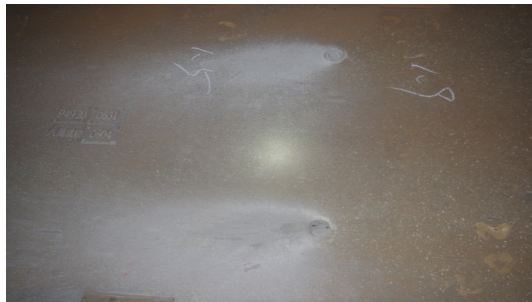
图 1-18 CA 砂浆灌浆孔喷浆
