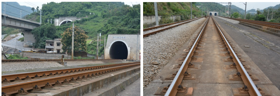
图 1-1 遂渝线无砟轨道试验段双块式无砟轨道
