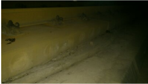
图 1-15 CA 砂浆层整体压出
