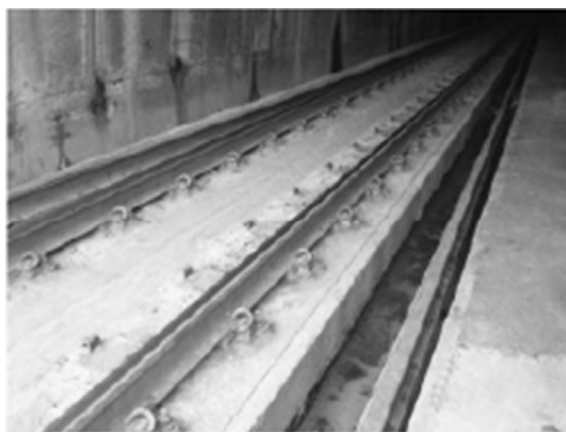
图 1-7 南非隧道内无砟轨道
