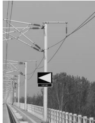
图 1-1-2 区间信号标志牌设于线路右侧
