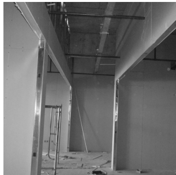
轻钢龙骨隔墙
