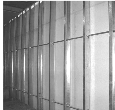
轻钢龙骨隔墙
