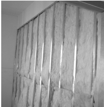
轻钢龙骨隔墙
