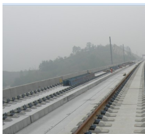
(b) 无砟桥面示意(高速)
