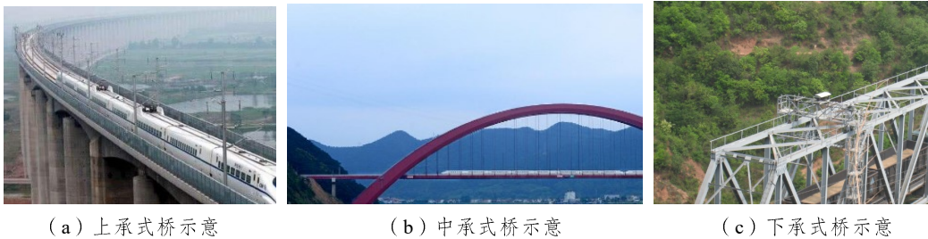
图 1-9 上承式、中承式、下承式示意
