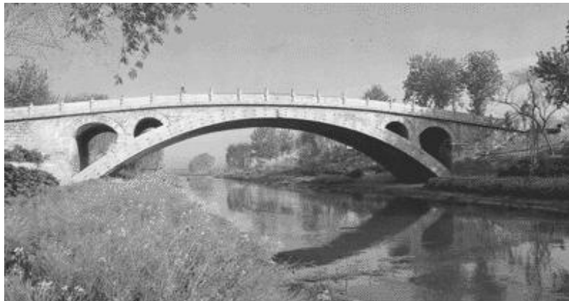
图 1.5 河北赵县洨河上的赵州桥(安济桥)
