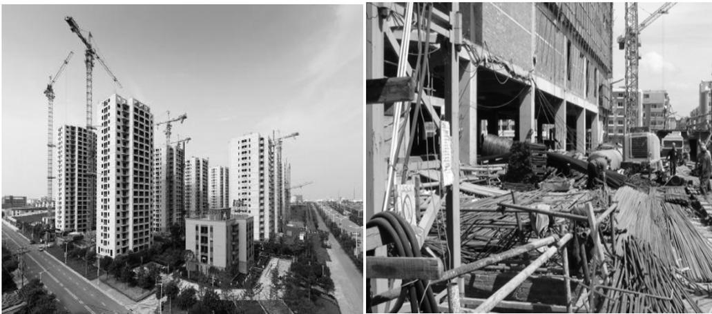
图 1-8 装配式施工现场与传统式现浇施工现场对比
