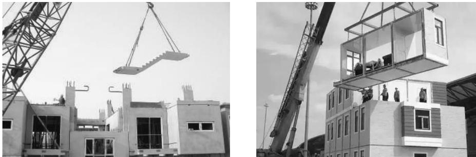
图 1-5 装配式施工
