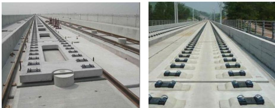
图 1-16 高速铁路某区段无砟轨道
