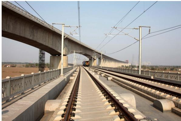
图 1-18 高速铁路接触网实景
