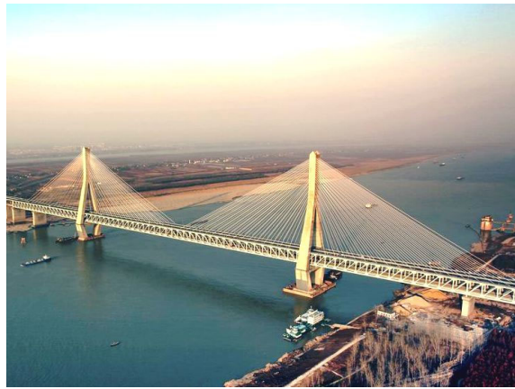
图 1.17 天兴洲长江大桥(2009 年)
