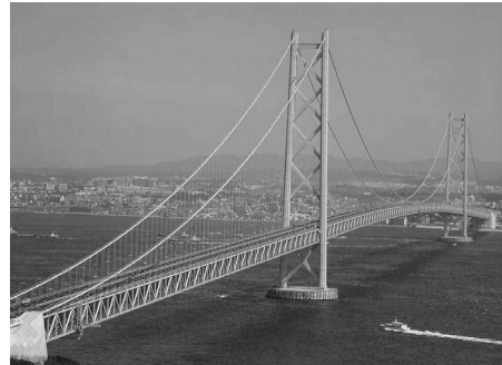
图 1.39 日本 Akashi Kaikyo 大桥 (1998 年)
