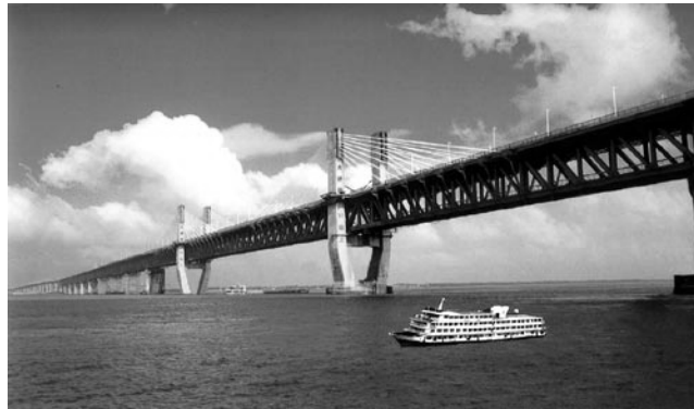
图 1.10 芜湖长江大桥(2000 年)
