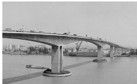
图 1.12 广东洛溪大桥（1988 年）
