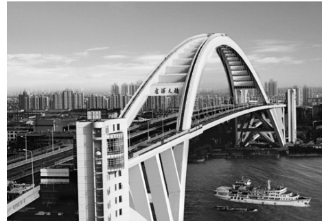
图 1.15 上海卢浦大桥(2003 年)
