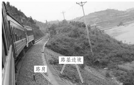
图 1-9 路基（路肩、路基边坡）
