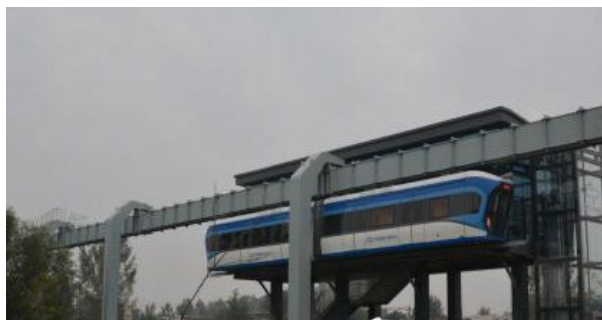
(b) 开封市悬挂式独轨系统示范段
