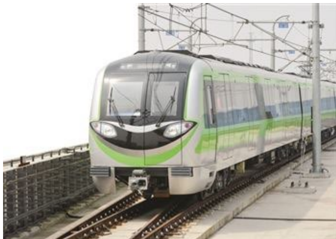
图 1-1 南京市轨道交通三号线
