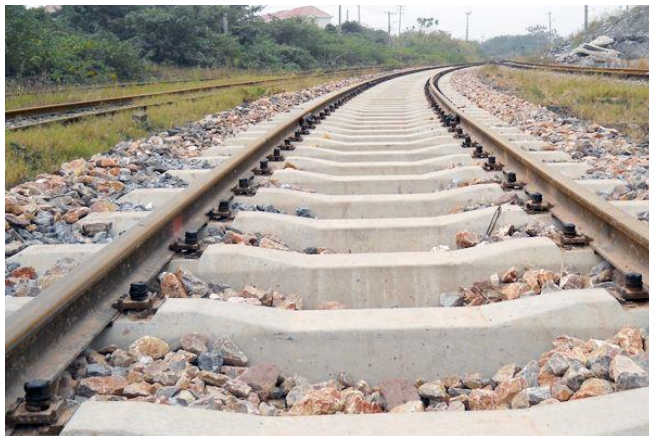
图 1-1-7 钢筋混凝土轨枕
