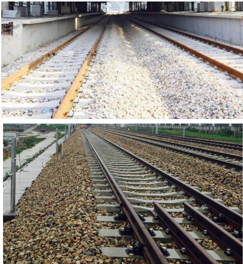
图 1-1-1 S1 线地面段线路情况
