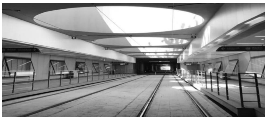
图 2-9 3 号线地下车站
