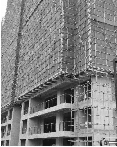
图 0.19 某在建商住楼
