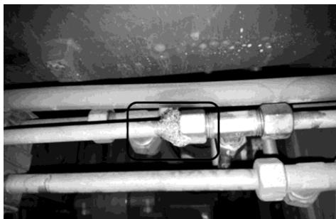
图 2.46 空气管路漏气
