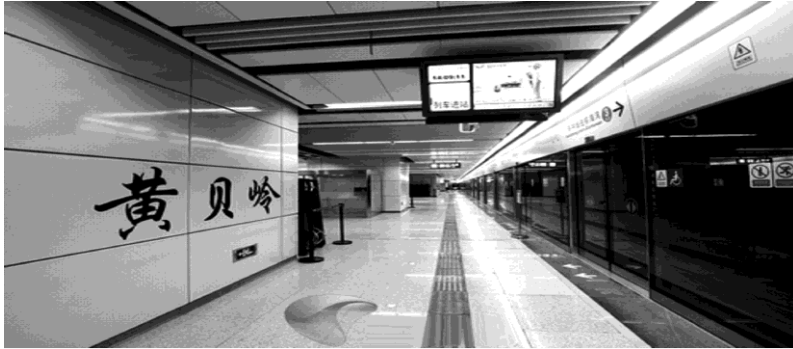
图 1-8 侧式车站的屏蔽门布局
