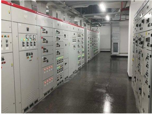
图 1-13 车站设备用房实物照片
