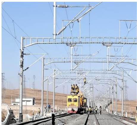
图 1-4 硬横跨及多线路腕臂用吊柱
