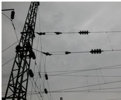
图 1-1 格构式钢柱
