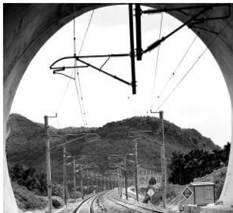
图 1-5 隧道内吊柱
