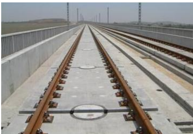
图 1-3 桥上 CRTS I 型板式无砟轨道
