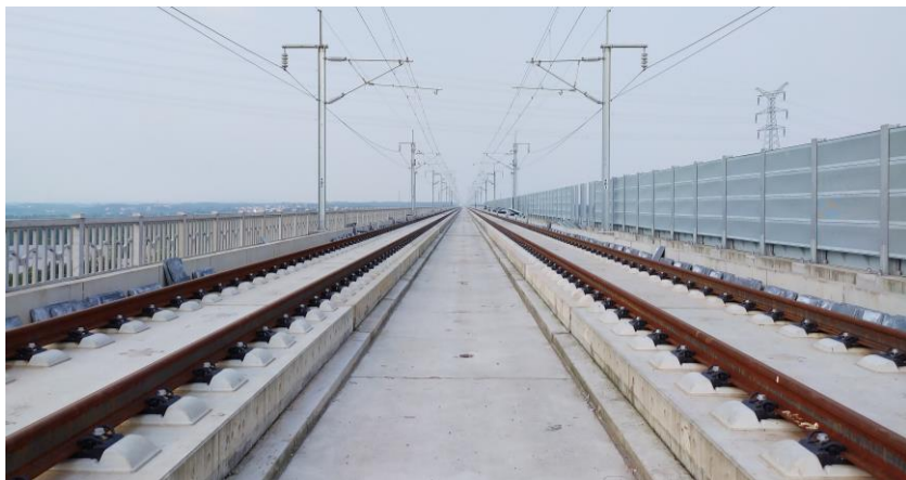
图 1-5 桥上 CRTSⅢ型板式无砟轨道
