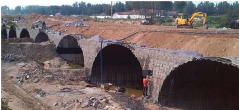
图 1.18 连拱型钢波纹板桥现场试验
