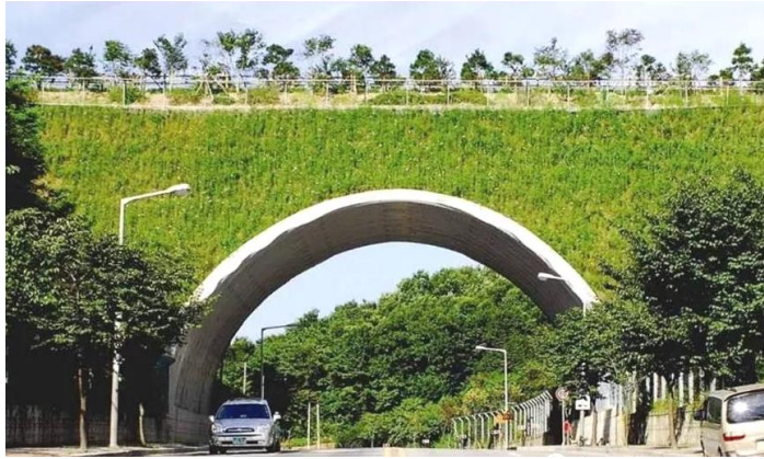
图 1.5 市政道路明挖隧道
