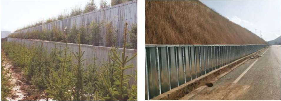
图 1.23 钢波纹板路基挡防工程
