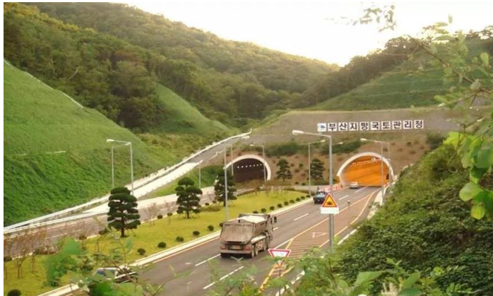
图 1.6 隧道洞门段
