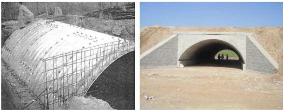
图 1.17 7.4 m 圆弧形钢波纹板试验桥
