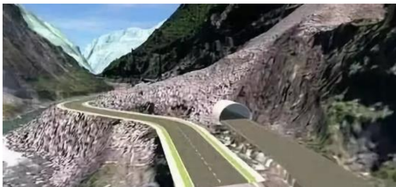
图 1.25 国道 213 线超大型坍方堆积体采用钢波纹板临时通道
