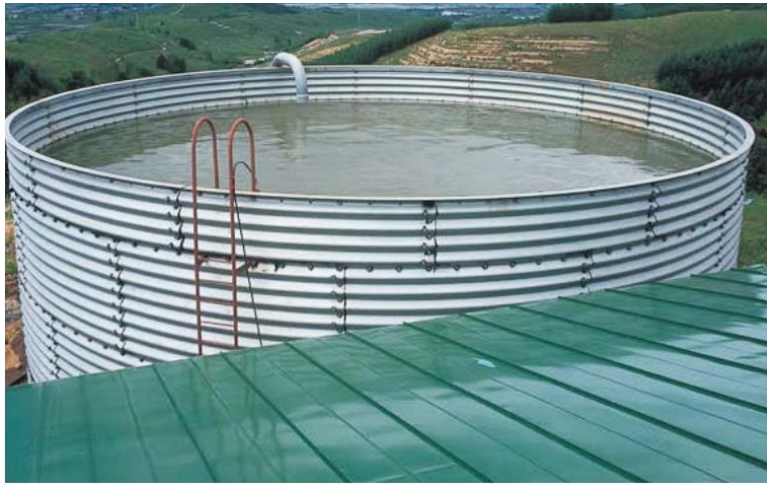
图 1.32 直径 30 m 钢波纹板蓄水池案例
