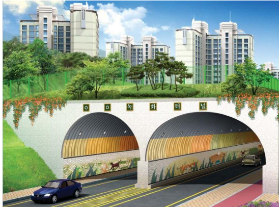
图 1.8 市政明挖隧道
