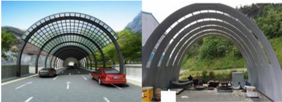
图 1.24 钢波纹板隧道渐进式透光遮光棚
