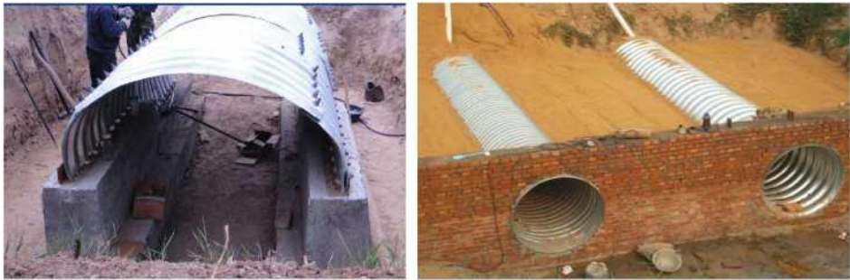
图 1.16 钢波纹板试验桥及涵洞
