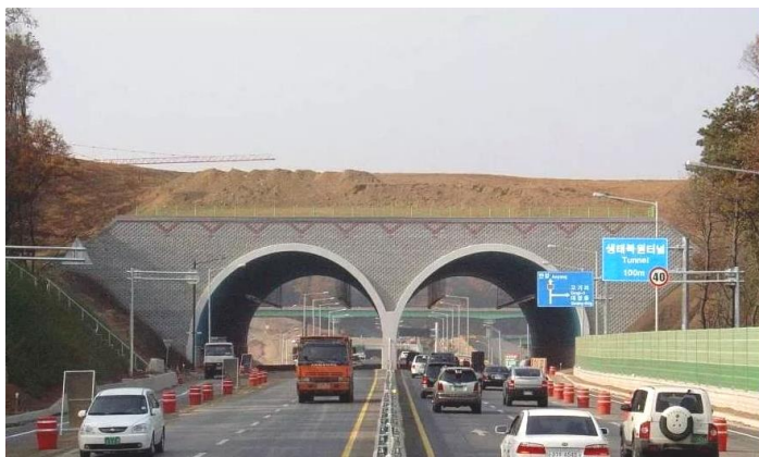
图 1.7 双孔明挖隧道
