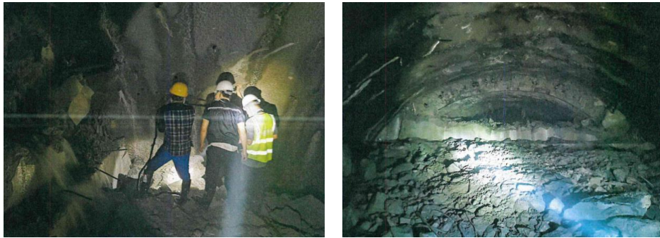
图 2.18 现场工作照片
