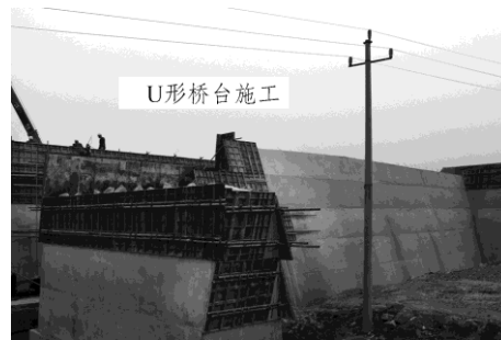
图 1-1-9 重力式 U 形桥台
