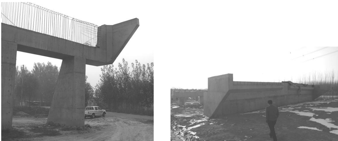
图 1-1-11 肋形（肋板式）埋置桥台
