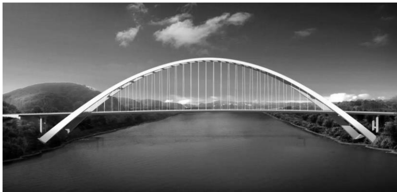
图 1-2-52 有推力梁拱组合体系桥
