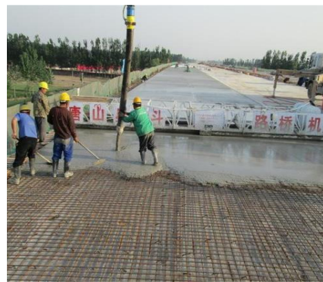
(b) 桥面层施工
