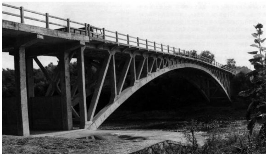
图 1-2-54 桁架拱桥（安城桥，主跨 65 m 的预应力混凝土斜压杆式桁架拱桥）
