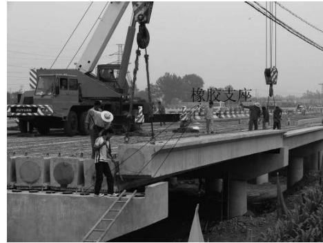
图 1-2-13 装配式梁桥施工
