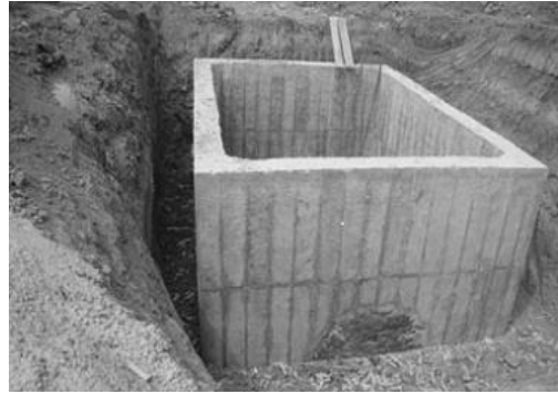
1—人孔；2—取土井；3—顶盖；4—凹槽；5—井壁；6—内隔墙；7—刃脚；8—封底。
