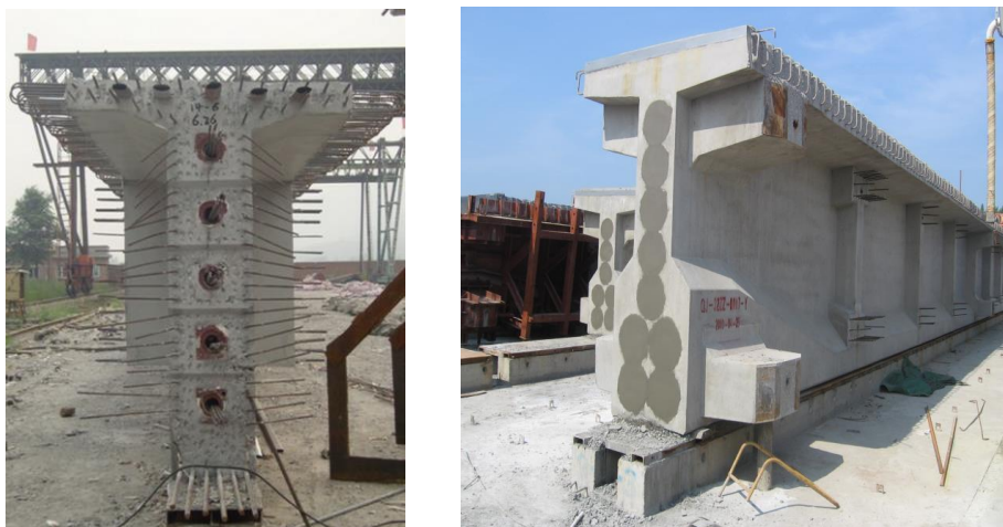
图 1-2-10 肋梁桥（T形梁）横断面
