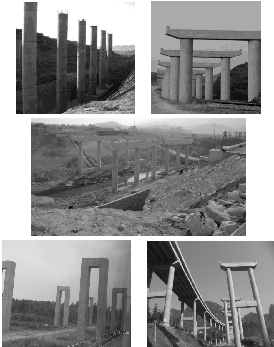
图 1-1-7 柱式桥墩实例图
