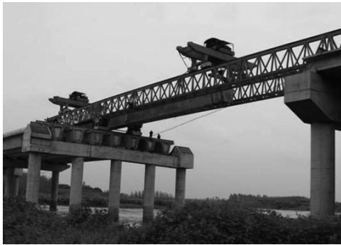
图 1-2-13 装配式梁桥施工
