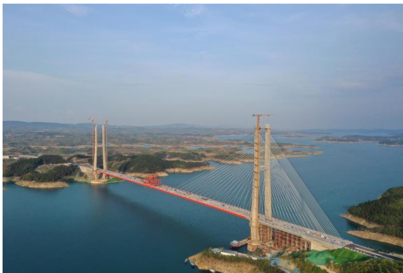
图 1-2-23 丹江口水库特大桥
