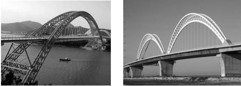
图 1-2-39 钢管混凝土拱桥
