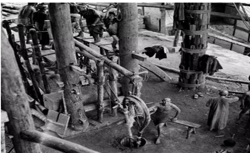
图 1 宋代发明的利用“冲击式顿钻法”钻凿的卓筒井
