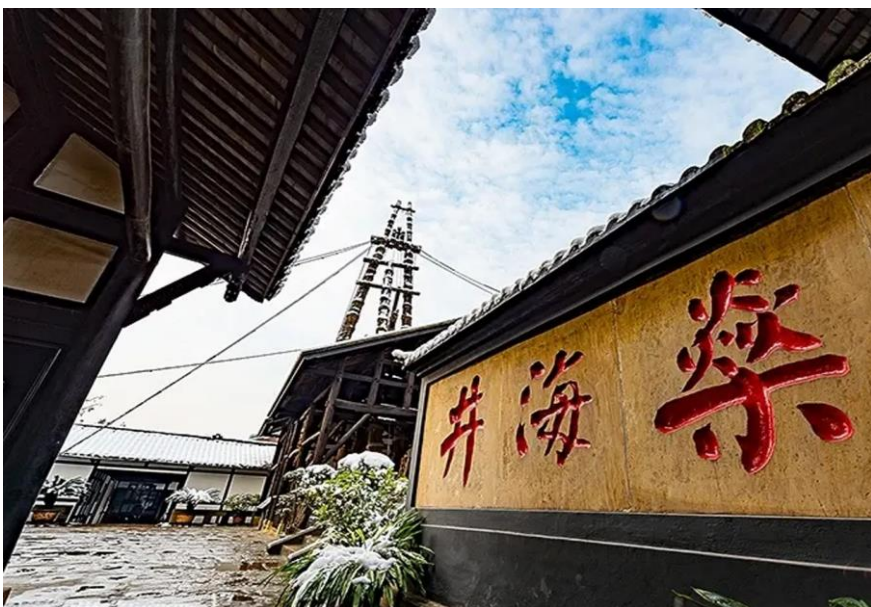
图 2 全球第一口超千米深井燊海井（开凿于公元 1835 年，井深 1 001.42 米）
