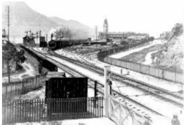
图 1-7 英国修建的香港铁路
