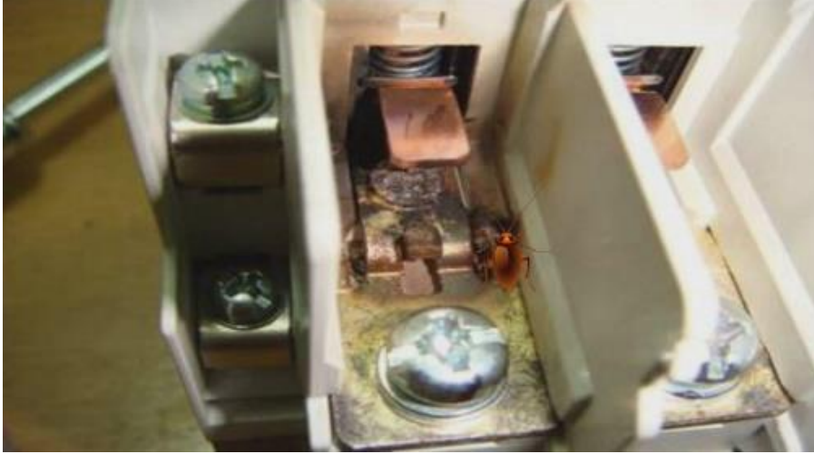
图 1-16 蟑螂尸体夹在接触器动静触头之间
