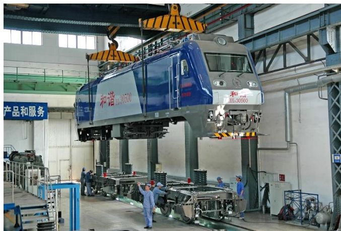
图 1-60 电力机车组装
