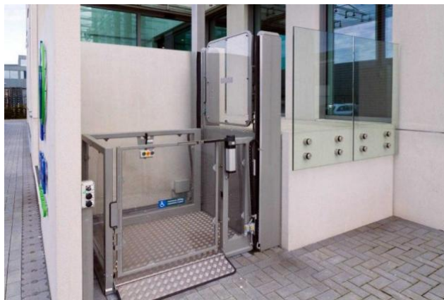
图 1-18 垂直式无障碍升降机（螺杆式）
