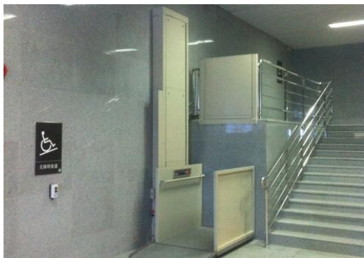
图 1-14 垂直式无障碍升降机（液压式）
